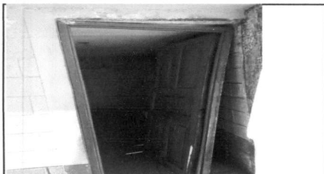
Foto 3: Sustitución de Puerta de Bodega.
