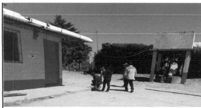
Foto 5: Mejoramiento de piso de torta de concreto en patio
