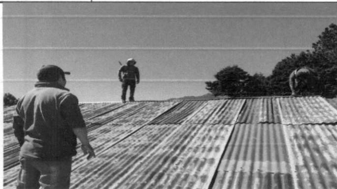
Foto 1: Sustitución de láminas en Techos
