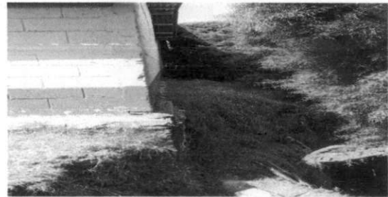
FOTO 8 SUSTITUCION DE CANALES Y BAJADAS DE AGUA
