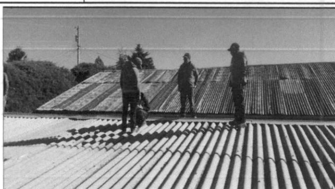
Foto: Sustitución de láminas en techos
