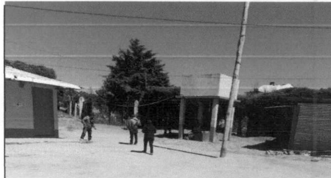
Foto 6: Mejoramiento de piso de torta de concreto en patio
