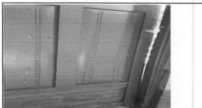
Foto 4: Sustitución de Puerta de Aula.
